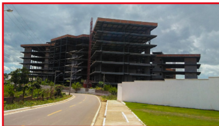
TCE-MA TAMBÉM DESCOBRIU INDÍCIOS DE SOBREPREGO NA CONSTRUÇÃO
