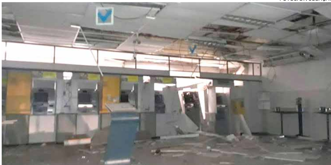
Destroços de agência destruída durante ação de assaltantes no interior do Estado
