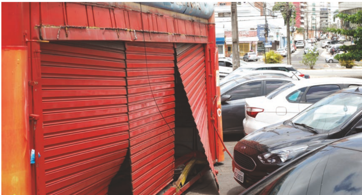
Danos ocorridos em bancas, durante retirada de local onde ficaram por 20 anos, serão sanados pela Semurh
