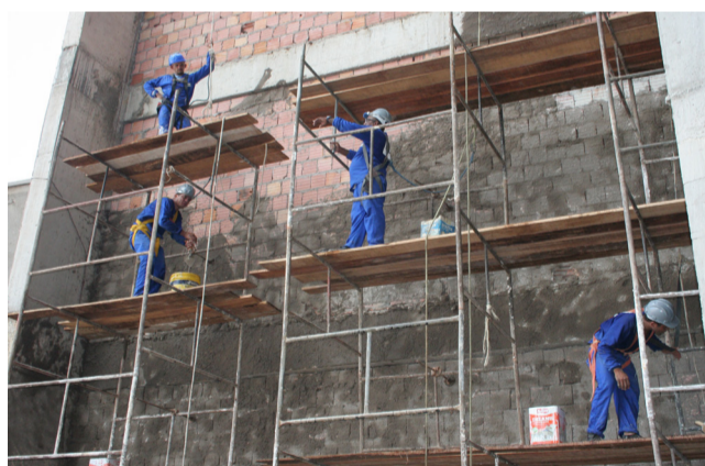
Construção do Anexo do Fórum de São Luís
