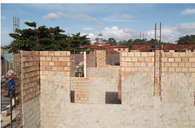
Construção do Fórum de Mirinzal
