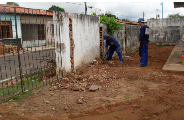
Reforma do Fórum de Coroatá
