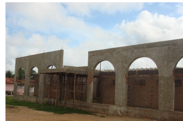
Construção do Fórum de Santa Inês
