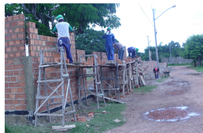
Construção do Fórum de São Mateus
