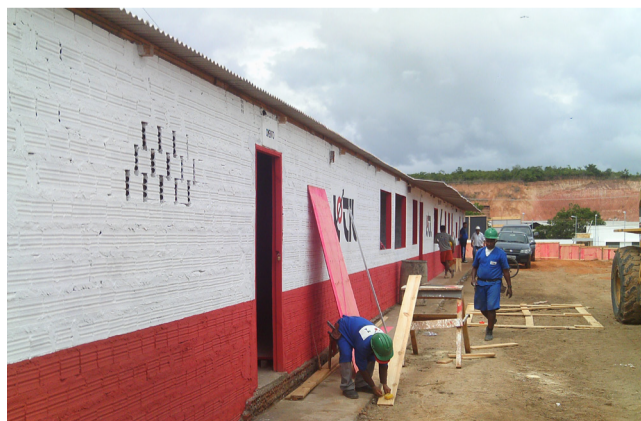
Construção do Fórum de Caxias
