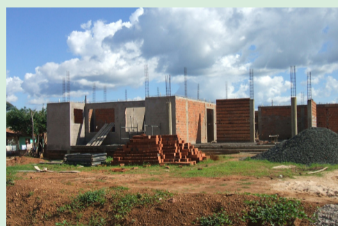
Construção do fórum de Mirador
