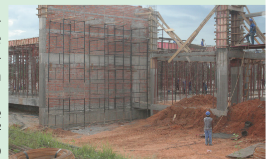
Obra de construção do fórum de Caxias
