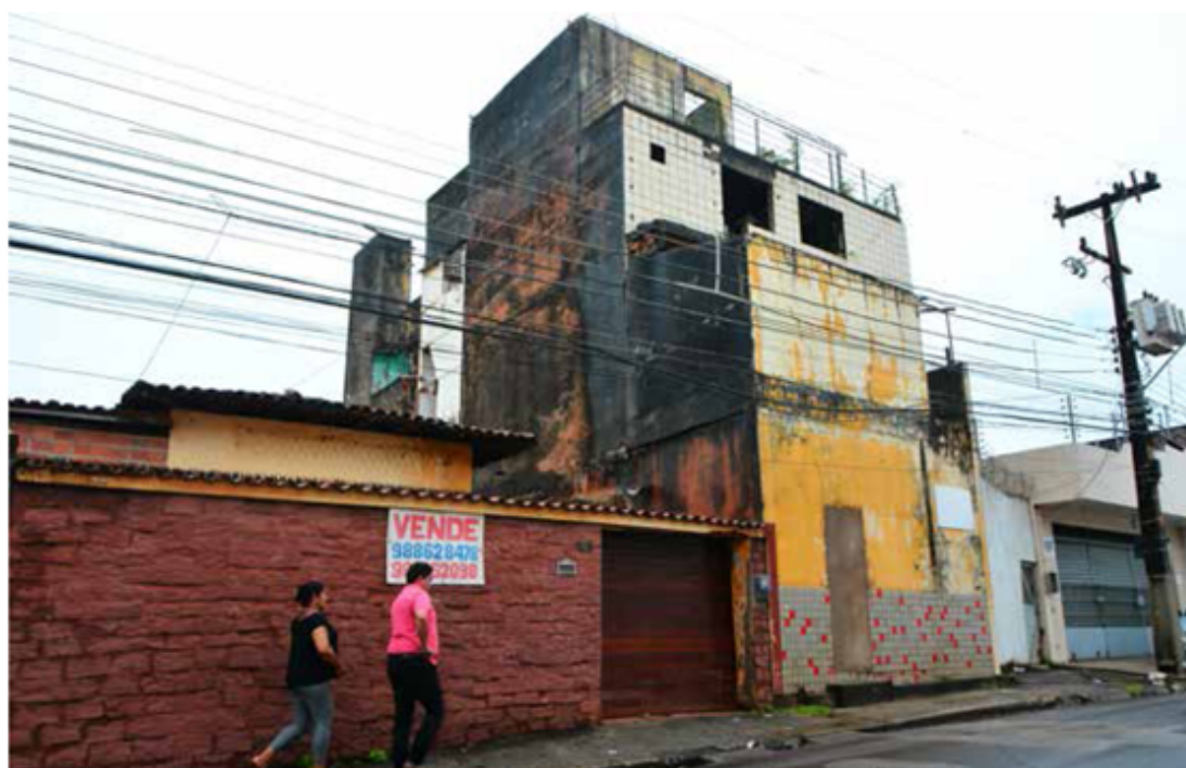
O prédio "Balança, mas não cai" e a antiga pousada "Momentos" causam medo em quem reside ou trabalha nas proximidades, devido ao risco iminente de desabamento
