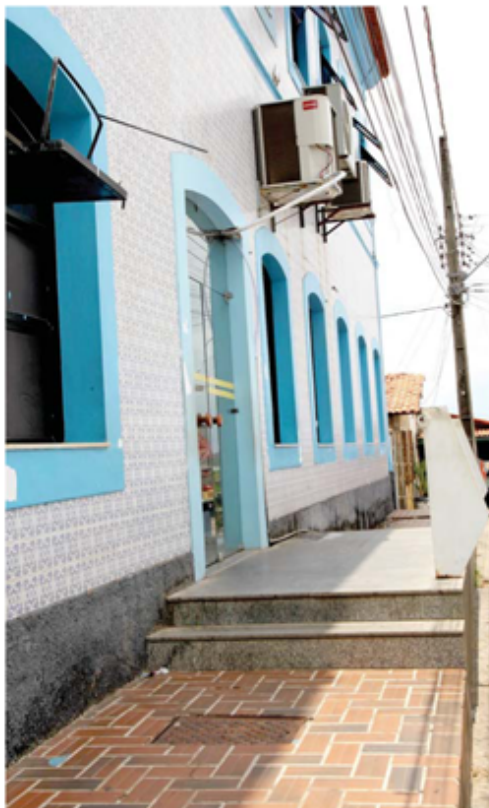
Hospital Geral: falta rampa para acesso de cadeirantes
