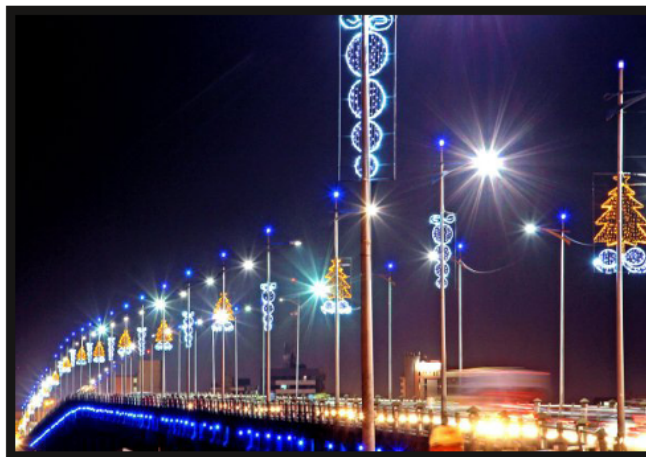
ILUMINAÇÃO DE NATAL INSTALADA NA PONTE
