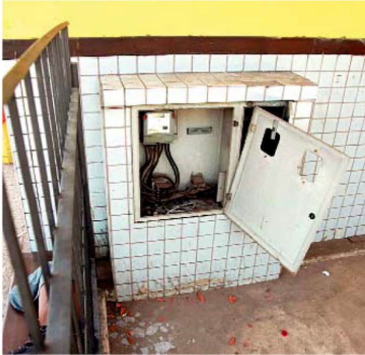
Caixa de disjuntores com tampa danificada no Terminal do São Cristóvão
