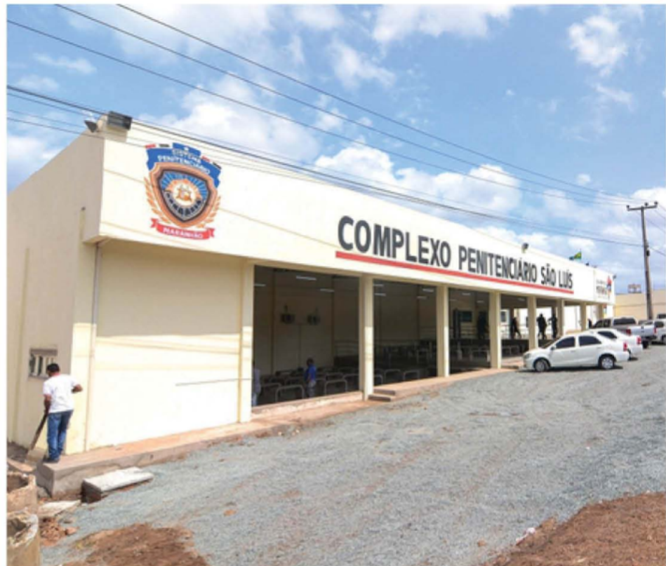
Nova estrutura conta com equipamentos de raio-x e BodyScan
