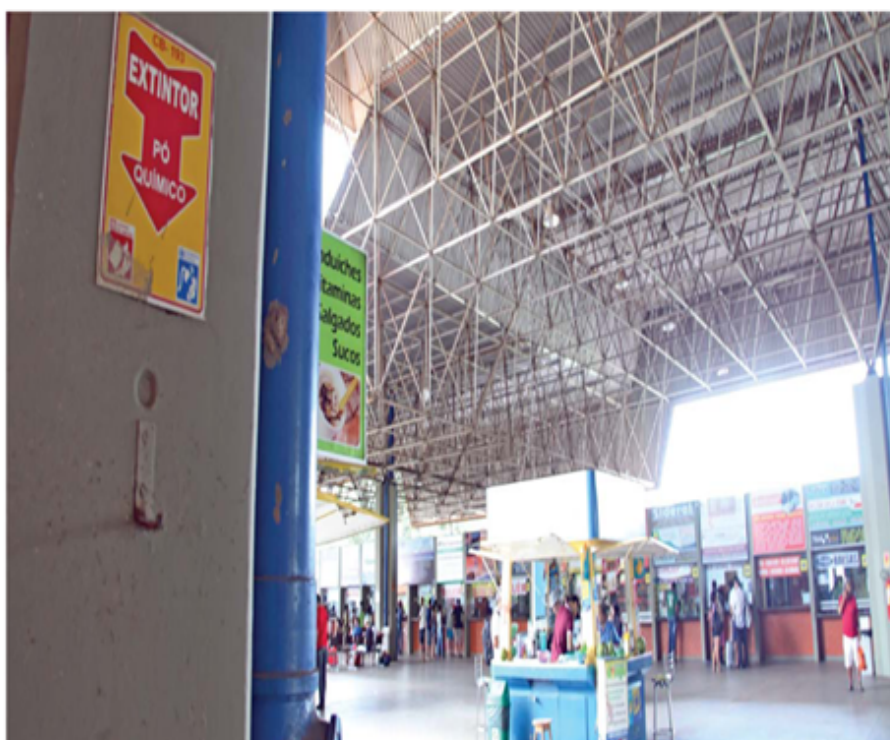
Entre os muitos problemas apresentados no Terminal Rodoviário de São Luís, faltam extintores de incêndio e lâmpadas no teto
