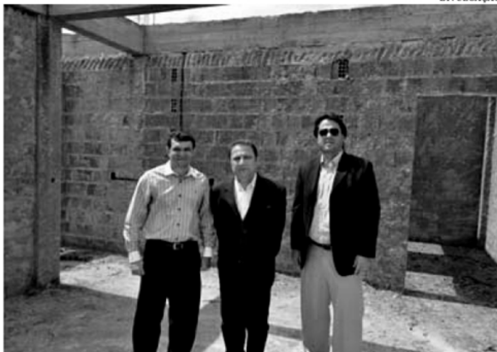
Corregedor-geral e juízes de Viana em visita às obras do fórum
