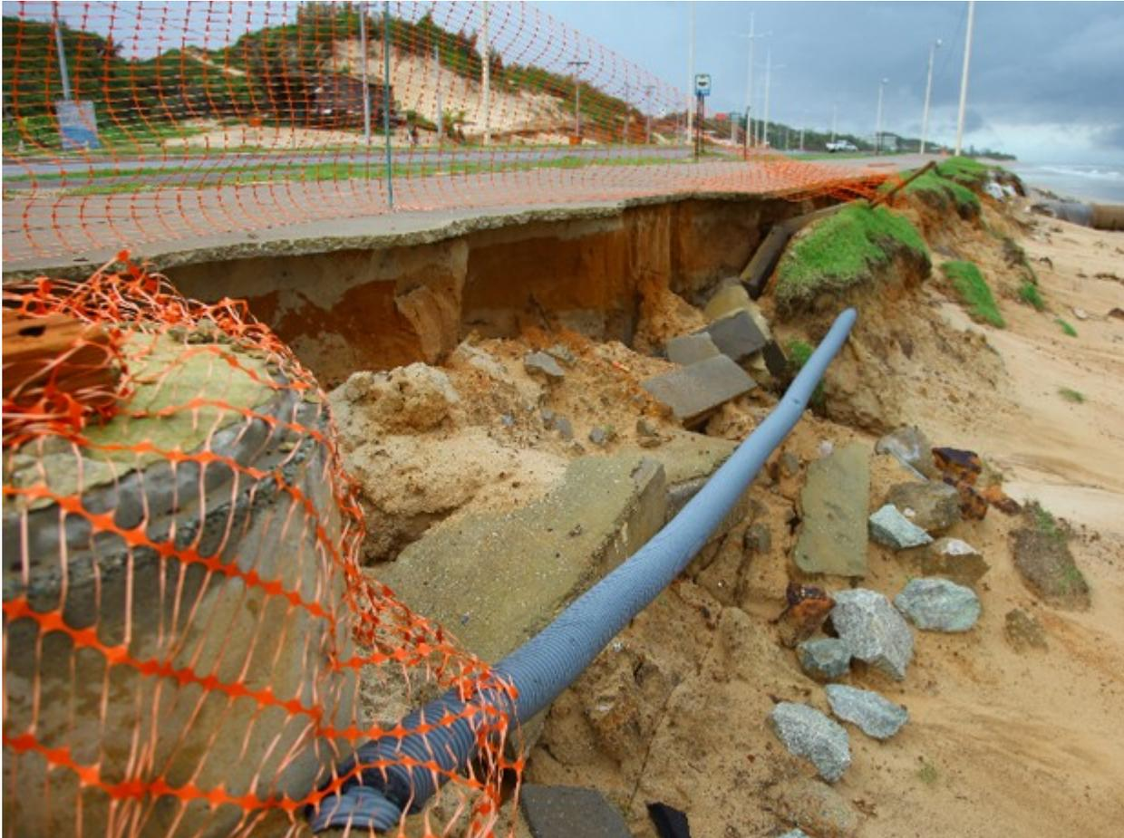
*Diversas rachaduras formaram-se ao longo do calçadão, comprometendo a estrutura da via (Foto: Biné Moraes/O Estado)*
