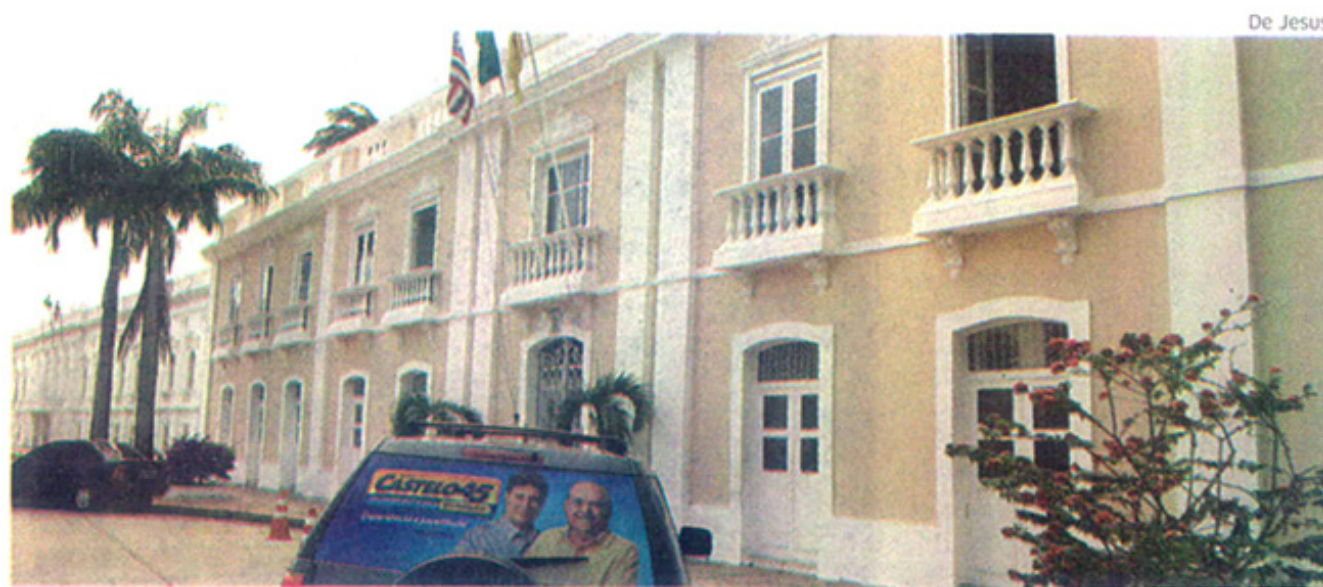
Palácio de La Ravardière, sede da Prefeitura de São Luís, teve o fornecimento de eletricidade cortado
