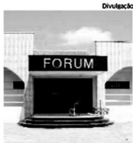
Fórum de Maracaçumé em obra
