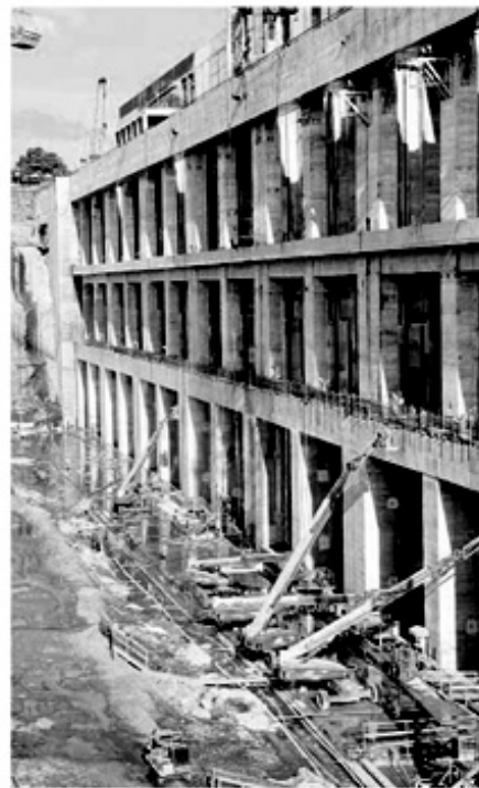
Casa de força da Hidrelétrica de Estreito está praticamente concluída
