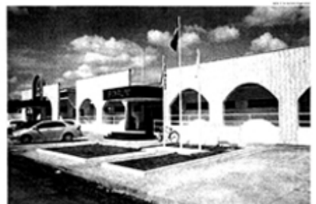
Fachada do novo fórum da comarca de Maracaçumé
