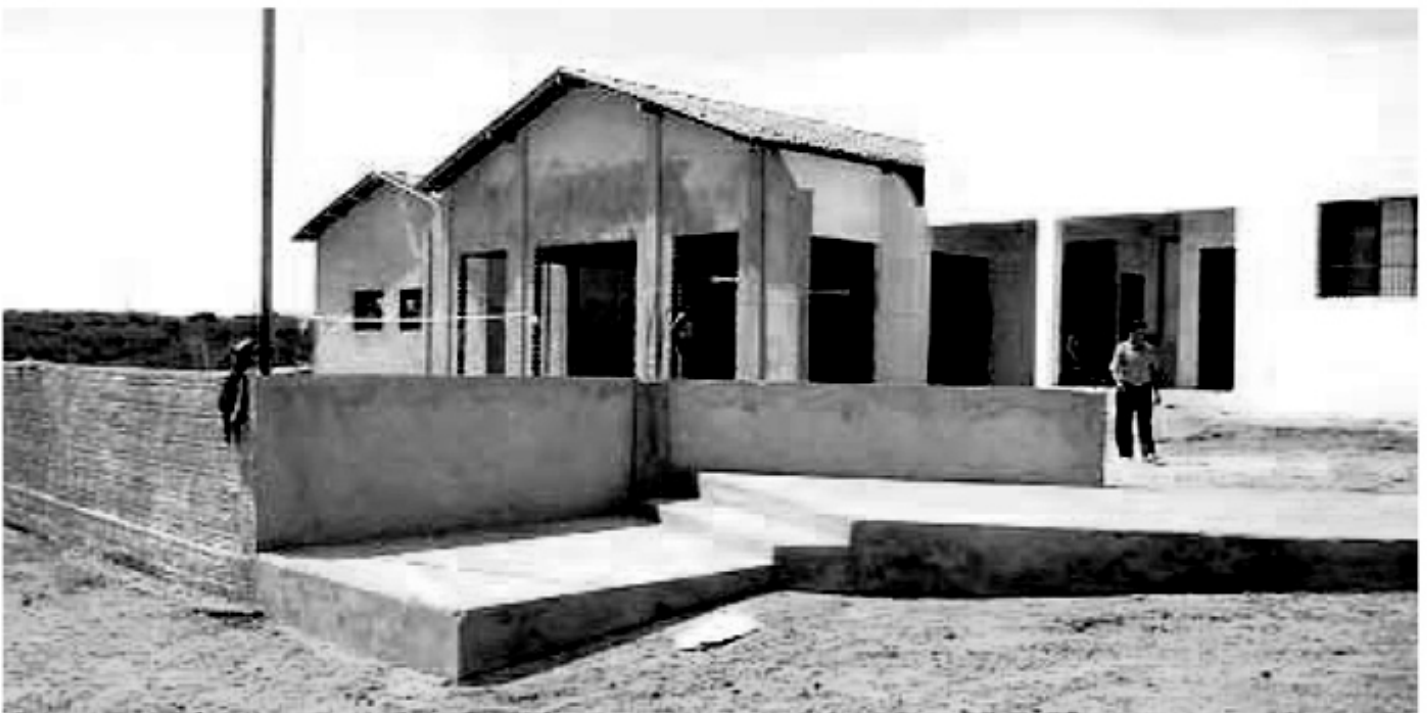
Obra de creche para filhos de detentos em sistema semi-aberto absorve internos no município de Timon
