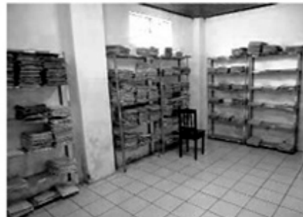
Armários com processos estão em ambiente úmido e com cupins
