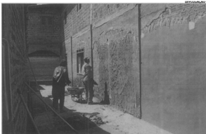
Operários trabalham na reforma do fórum do município
