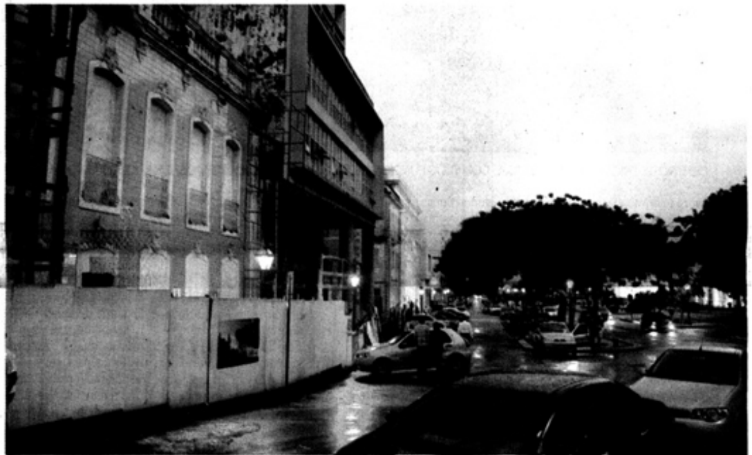
CASARÃO ABANDONADO AO LADO DO ANTIGO PRÉDIO DO INSS. ESTE PASSA POR REFORMA QUE JÁ DURA MAIS DE DEZANOS
