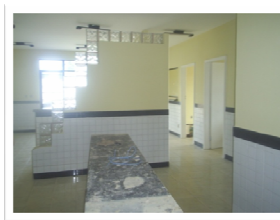
DEPOIS – COLOCAÇÃO DE REVESTIMENTO CERAMICO EM PAREDES
