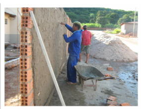
DURANTE – MURO EM CONSTRUÇÃO
