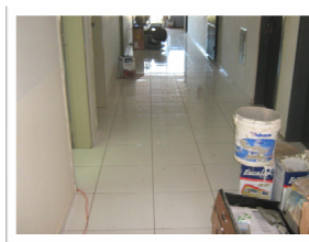
DURANTE – NOVO PISO CERAMICO
