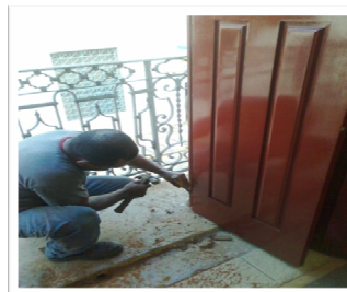
PORTAS EM MADEIRA SENDO TROCADAS
