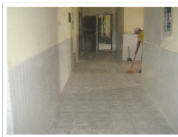
COLOCAÇÃO DE REVESTIMENTO EM PAREDES
