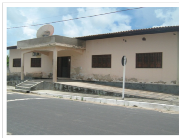
RECUPERAÇÃO DA FACHADA PRINCIPAL
