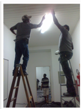
SERVIÇOS DE PINTURA GERAL
