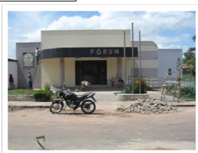
ANTES – FACHADA PRINCIPAL
