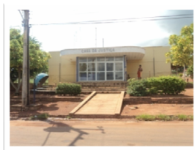
ANTES – FACHADA PRINCIPAL
