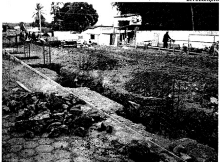
Obra de reforma e ampliação do fórum de São José de Ribamar
