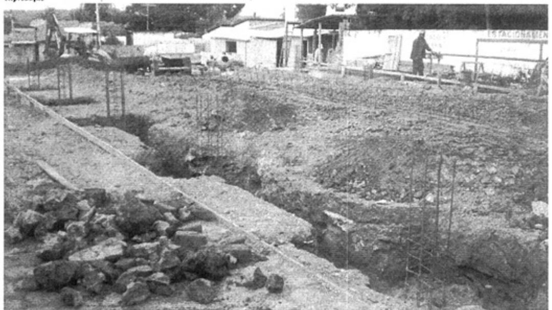
Reforma e ampliação do fórum de São José de Ribamar
