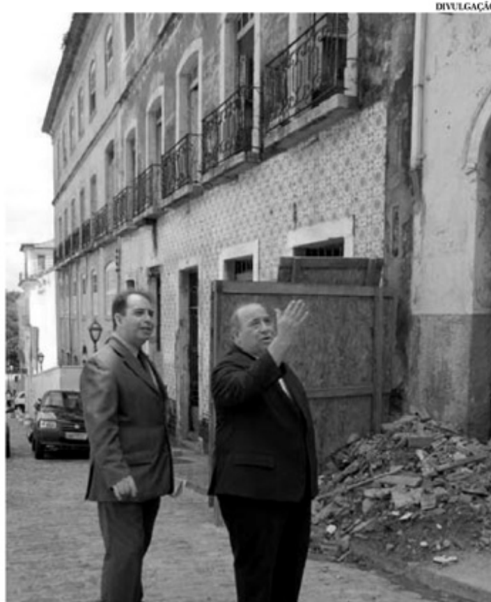
Guerreiro Júnior e o diretor Rui Barbosa visitam um dos prédios históricos do TJ em obras
