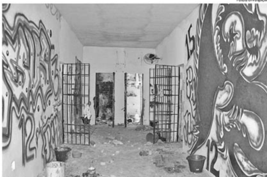
Ala da Casa de Detenção que foi destruída durante a rebelião do dia 9 e está sendo reformada
