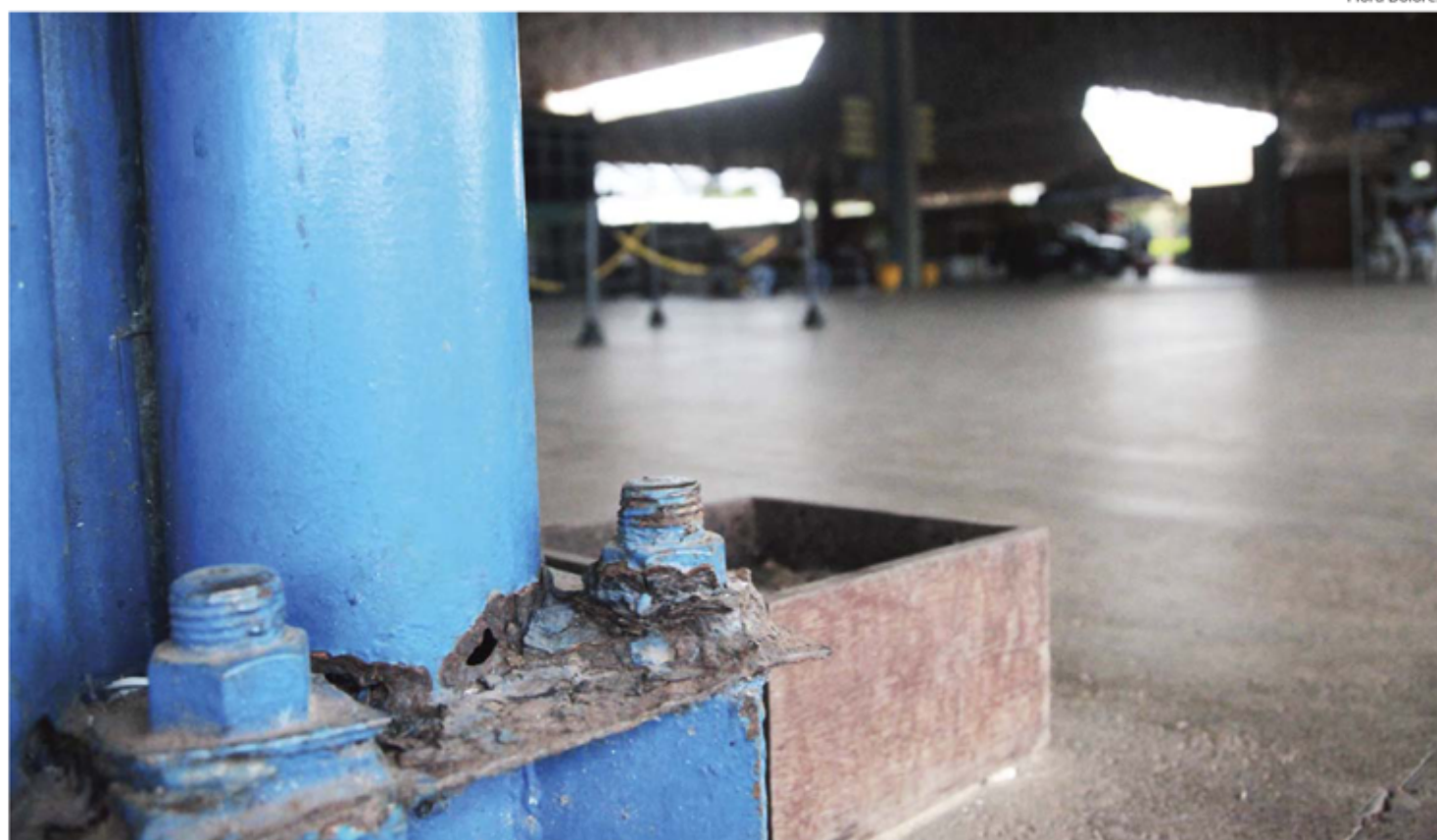
Estrutura de ferro do Terminal Rodoviário com ferrugem e parcialmente deteriorada demonstra a insegurança do local para usuários
