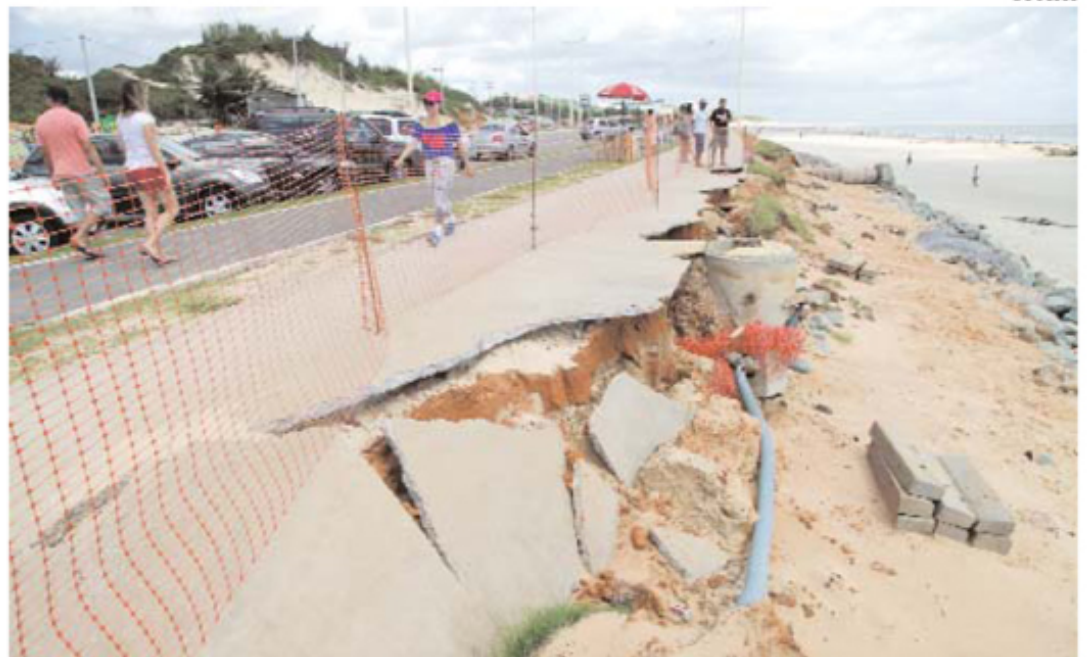
Trecho da avenida que está cedendo, pondo em risco a vida das pessoas que fazem caminhadas pela área
