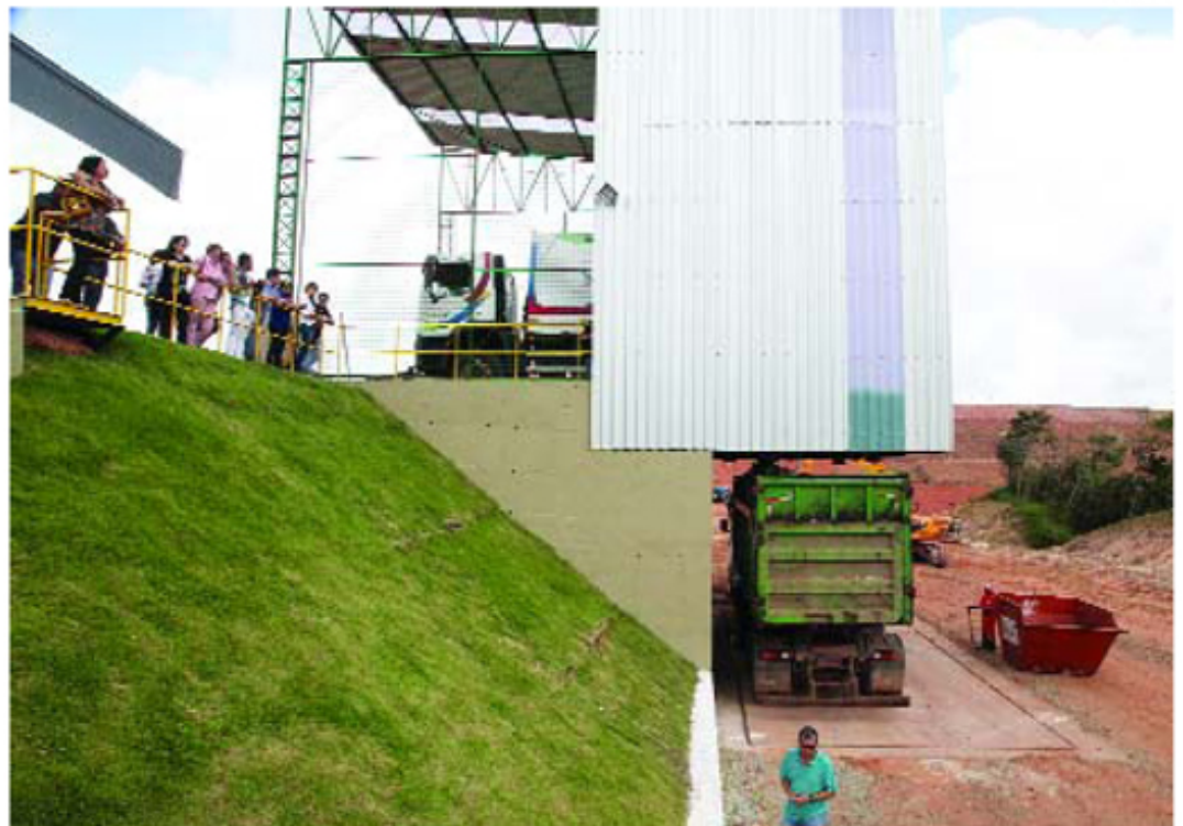
Em estação de transbordo, caminhões recebem lixo que será transportado para a cidade de Rosário
