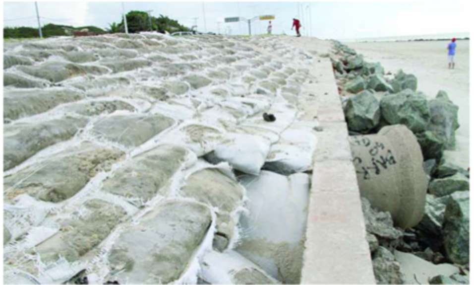
Barreira reconstruída ao lado do calçadão já apresenta novo buraco
