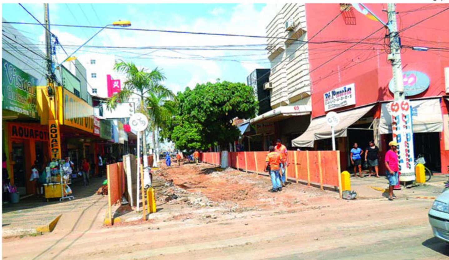
Calçadão no Centro Comercial de Imperatriz terá uma via para circulação de transporte de emergência
