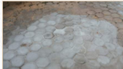
2º JUIZADO-UEMA - Reparo no pavimento de bloco de concreto
