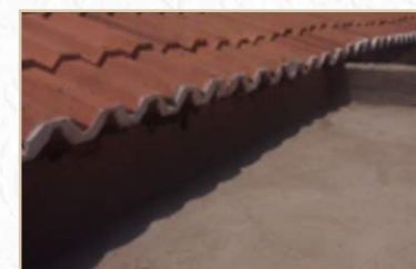
Mureta para proteção da chuva
