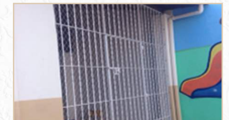
Creche Judith Pacheco - Instalação de tela de proteção de nylon com ganchos em inox
