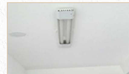
JUIZADO ESPECIAL CÍVEL E CRIMINAL DE RIBAMAR - Instalação de luminárias
