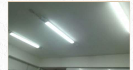
7º JUIZADO (CEUMA-RENASCENÇA) - Substituição de luminárias
