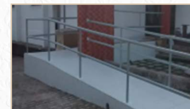
Rampa de acesso
