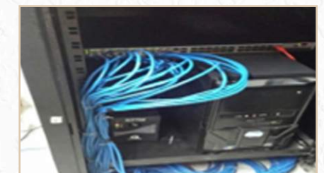
FÓRUM e JUIZADO DE RIBAMAR - Instalação de infraestrutura para CFTV
