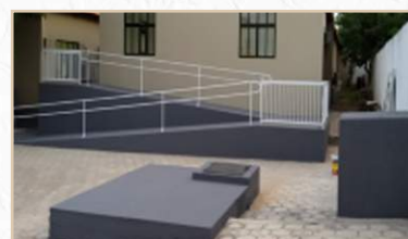
Rampa de acesso ao Fórum
