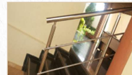
CASA ABRIGO - Instalação de guarda-corpo
