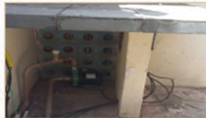
Casa da Criança (Apeadouro) - Substituição da bomba d'água
