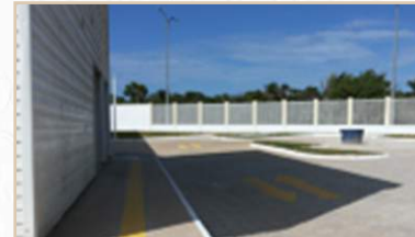
Piso tátil para pessoas com Mobilidade Reduzida
