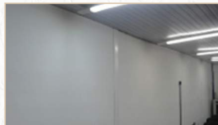
ESMAM - Criação de pontos elétricos e pintura no Auditório
