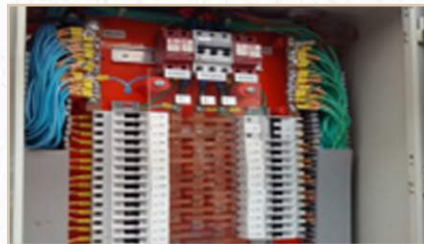
Creche Judith Pacheco (Centro) - Reparo no quadro elétrico
