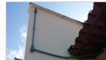
JUIZADO DE RAPOSA - Instalação de infra-estrutura para CFTV
