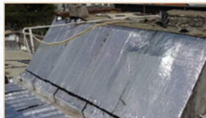
ESMAM - Impermeabilização na cobertura
