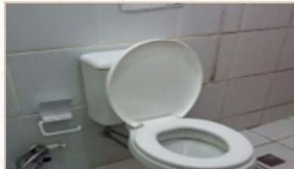
CASA ABRIGO - Substituição de 2 vasos sanitários com caixa acoplada
