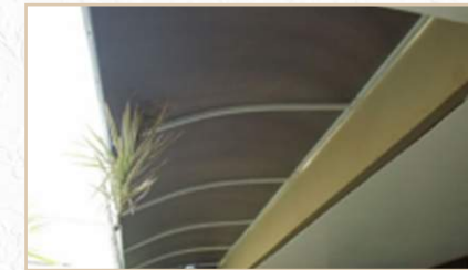
CASA ABRIGO - Instalação de toldo fixo
