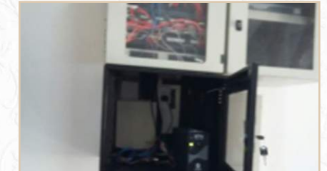
1ª VARA (DEODORO) - Instalação de rack
