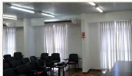
ESMAM - Instalação de três condicionadores de ar de 60.000 btu's
