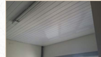
12º JUIZADO - Instalação de forro em PVC branco, na Copa
