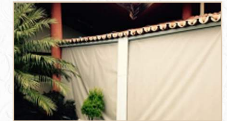
CASA ABRIGO - Instalação de toldo fixo
