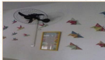
CASA DA CRIANÇA - Instalação de pontos elétricos e ventiladores de parede
