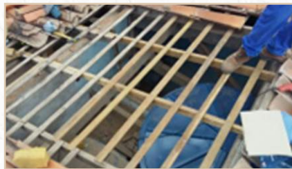
4º JUIZADO (CSU-COHAB) - Substituição de caixa d'água e reparo na cobertura
