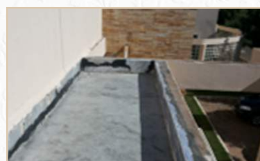
Impermeabilização da Laje
