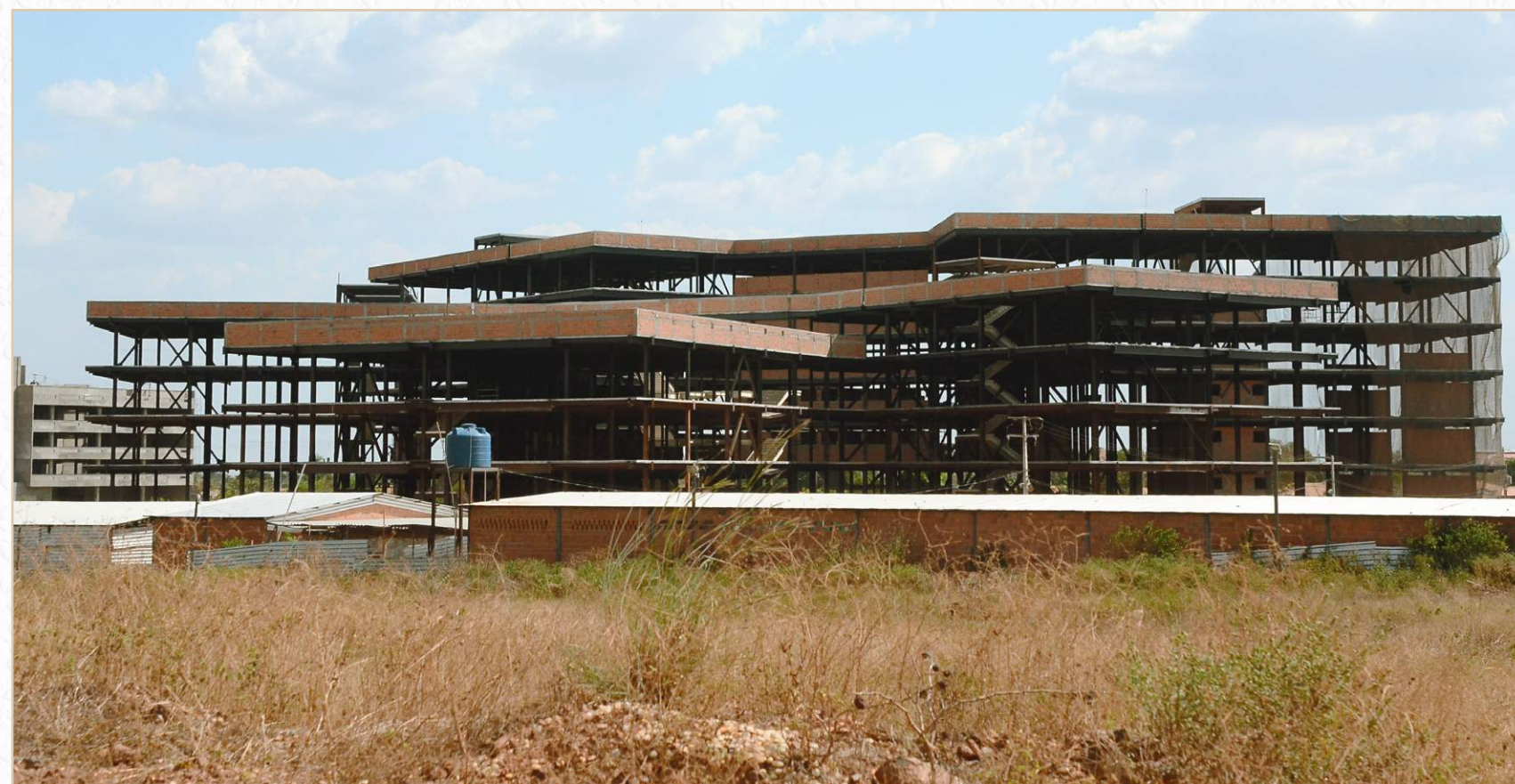
Obra do Fórum de Imperatriz
