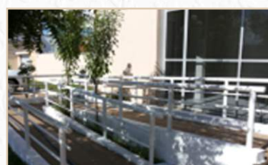
Rampa de Acessibilidade
