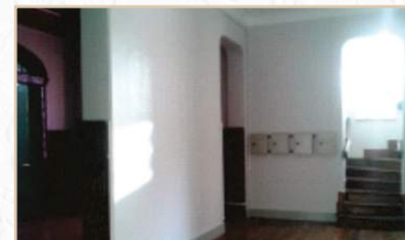
Tratamento do piso em madeira
